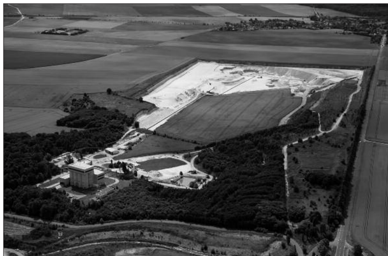
Exploitation de sables de Crépy-en-Valois en Picardie [Source Sibelco France]
