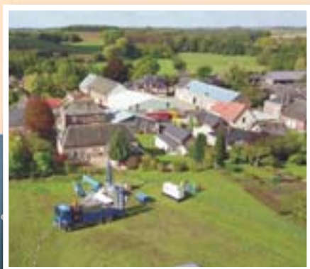
Forage de géothermie sur nappe à Monchy-Lagache (Somme).
