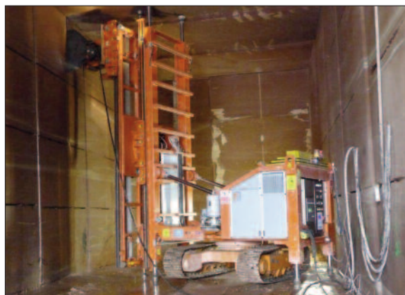
L'exploitation souterraine recourt à une haveuse Fantini.
