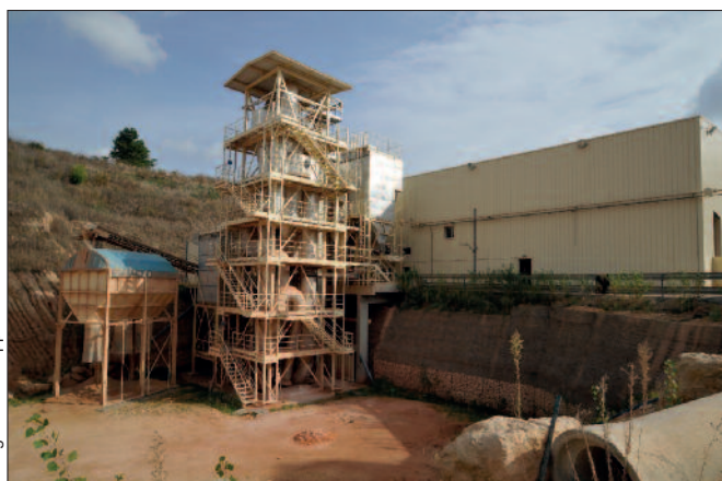
Argeco Développement : tour de calcination « flash »
