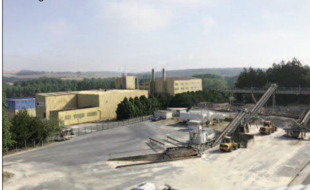
Les installations industrielles du sable verrier à Montgru-Saint-Hilaire.
