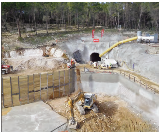
Le chantier du tunnel à l'entrée Jadots.
