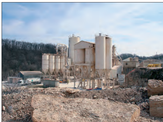
Installation de traitement de la chaux (groupe Saint-Hilaire).
