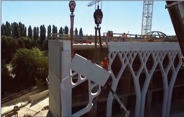
Montage et assemblage des 20 éléments de la façade, en forme d'arbre, de la mosquée de Mulhouse par la société BCS. Chaque pièce mesure 13 m de haut et pèse 12 t.
