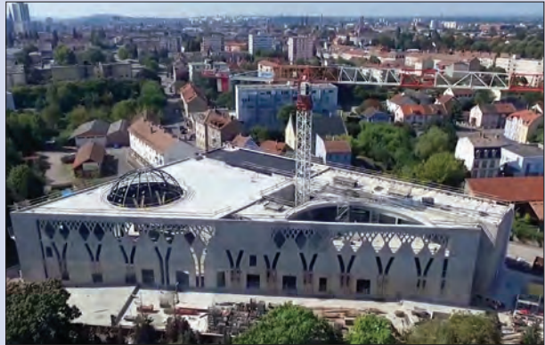
Montage et assemblage des 20 éléments de la façade, en forme d'arbre, de la mosquée de Mulhouse par la société BCS. Chaque pièce mesure 13 m de haut et pèse 12 t.
