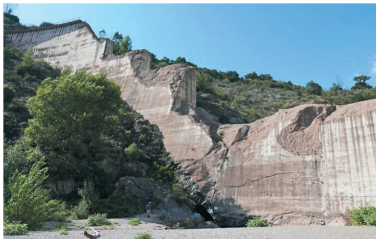
2. La partie droite du barrage : au centre et en bas de l'image, dans l'ombre, la roche se délite et le béton est moins bien porté, d'où l'importante fissure horizontale.
