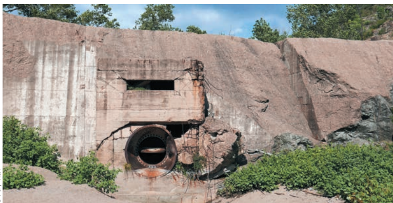
3. La vanne qui servait à vider le barrage est toujours en place.
