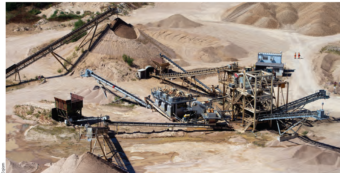
Installation de traitement de Saint-Éloi (au milieu, le nouveau système de traitement de sable).
