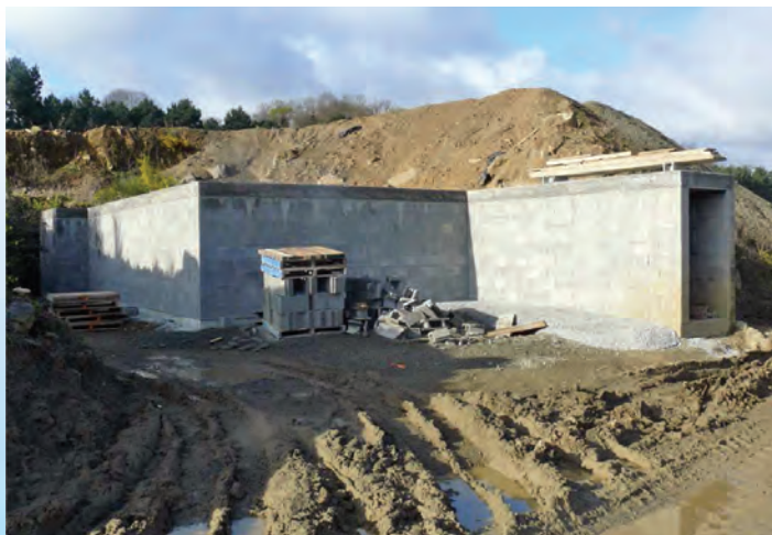
Le tunnel à chauve-souris a été recouvert de 3 m de terre pour maintenir une température et une hygrométrie constantes.
