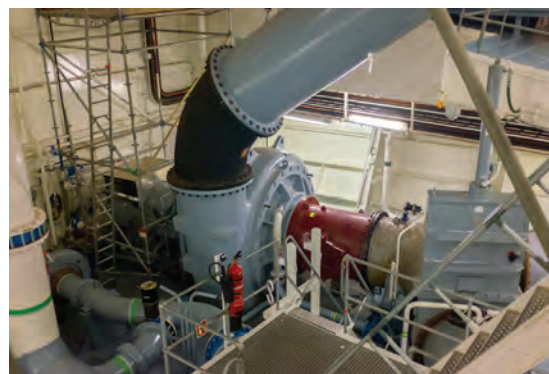
La pompe qui permet de draguer le sable en mer. A droite, la guillotine répartit les flux de sable pour prélever ou livrer, à la proue du navire.
