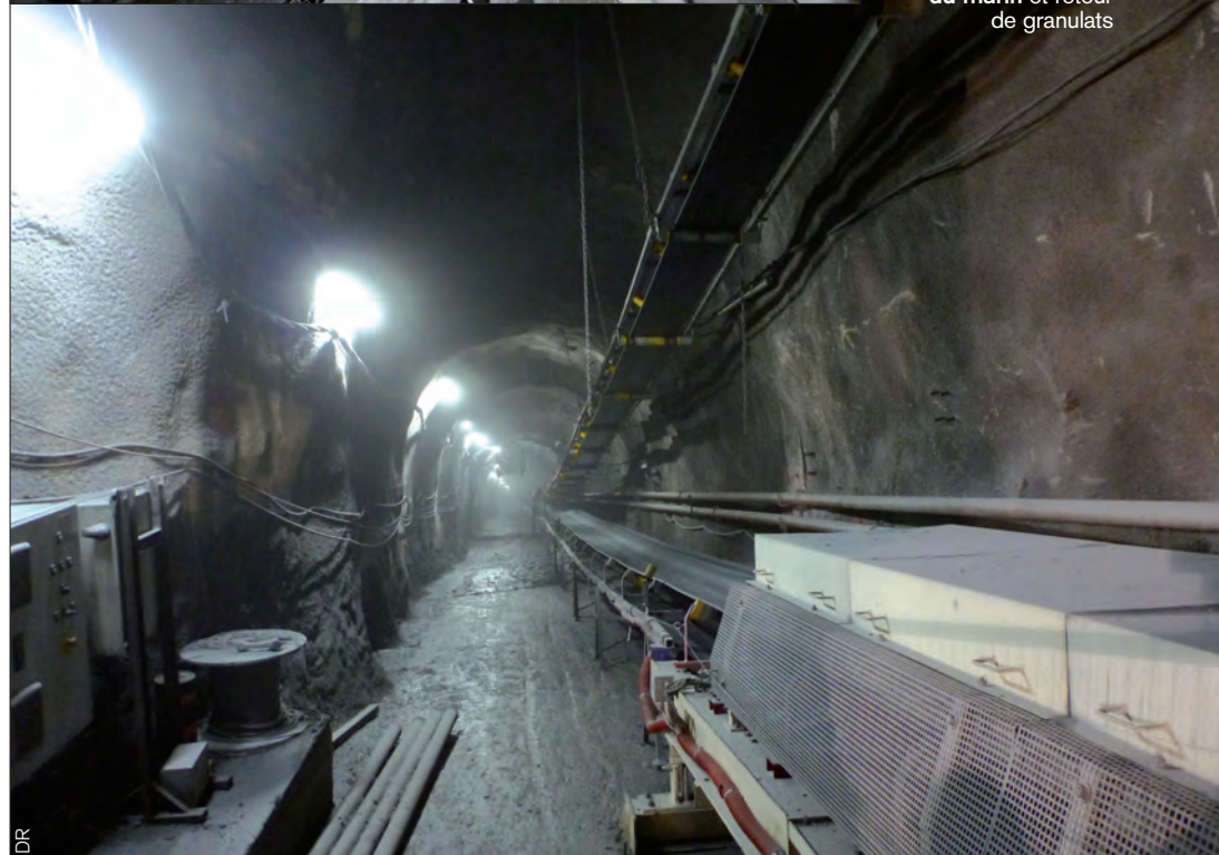
Galerie d'extraction du marin et retour de granulats
