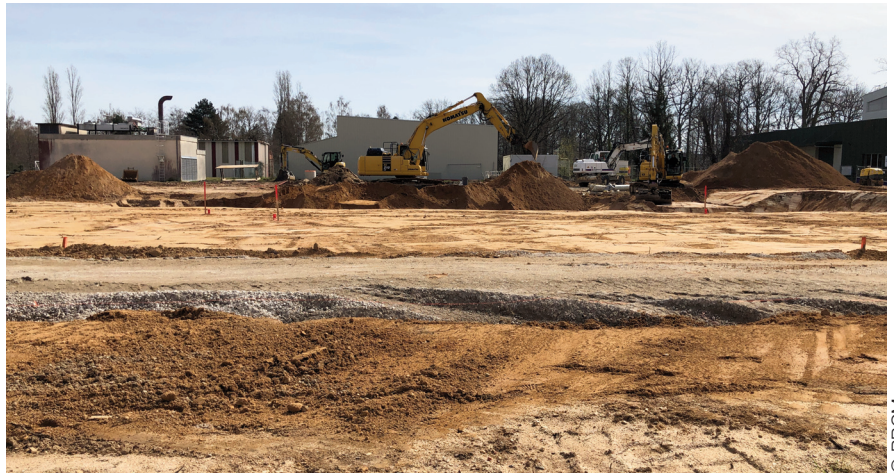
Chantier Batlab au BRGM à Orléans.
