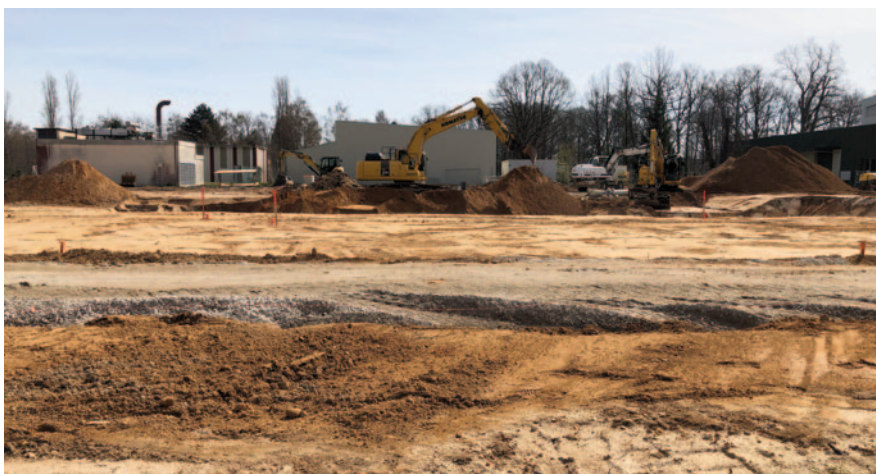
Chantier Batlab au BRGM à Orléans.
