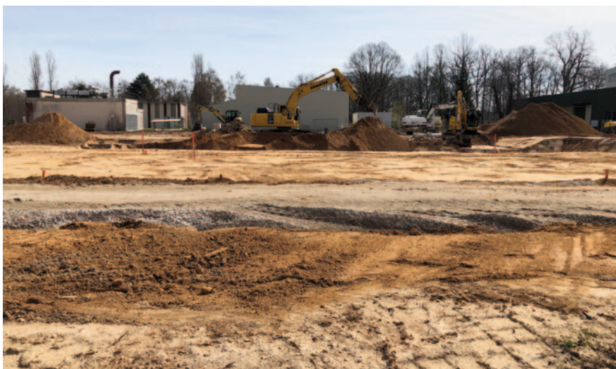
Chantier Batlab au BRGM à Orléans.
