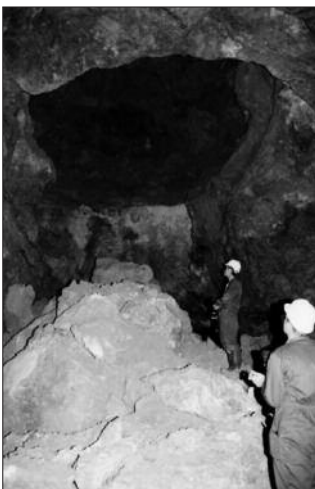
Figure 5 - fontis dans la carrière souterraine de gypse de Roquevaire (Bouches-du-Rhône) [crédit Ch. Mathon BRGM]
