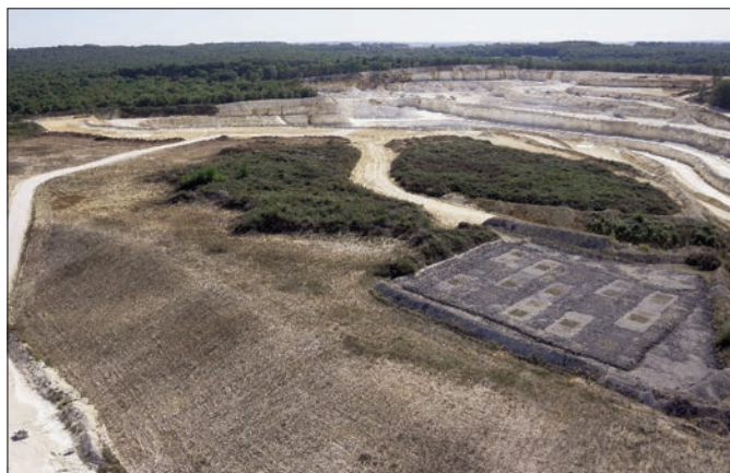
La carrière et son réaménagement.
