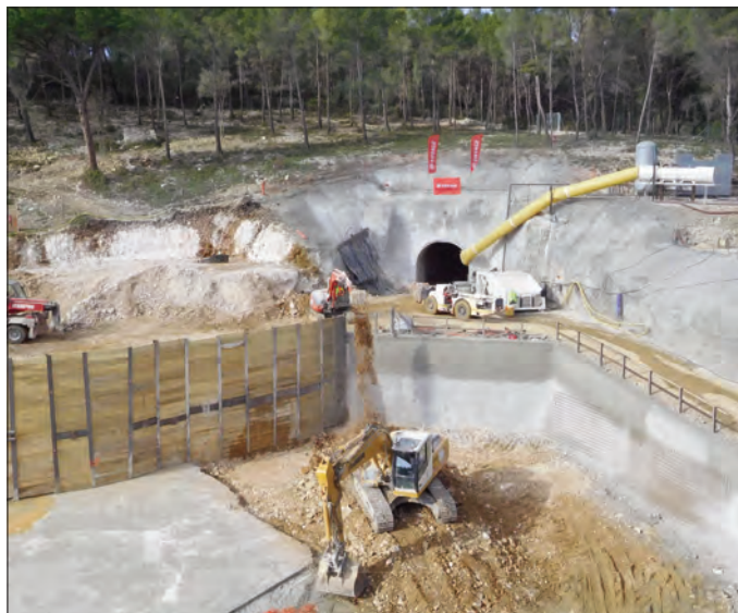
Le chantier du tunnel à l'entrée Jadots.
