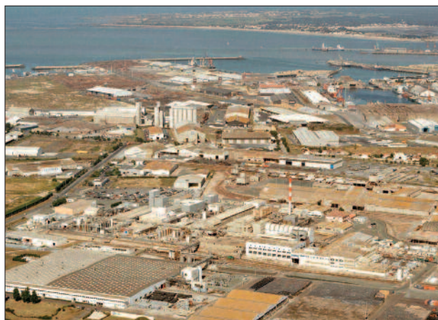
Vue aérienne du site Solvay de La Rochelle
