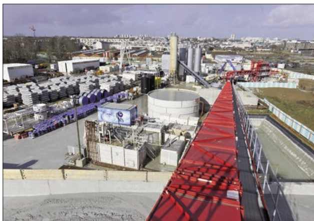
Chantier du métro de Rennes, ligne B.
